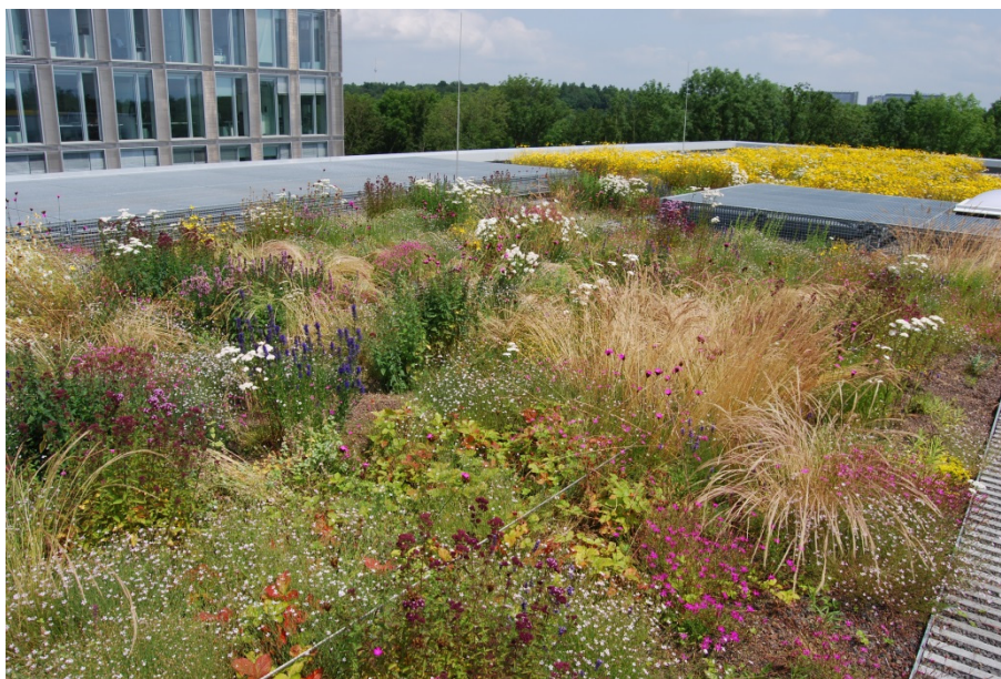
Abbildung 1 Extensiv begrüntes Dach auf einem Gebäudekomplex der EnBW City GmbH & Co. KG in Stuttgart, Baujahr 2007 (Foto © OPTIGRÜN).
