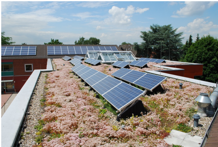
Abbildung 10 Kombination aus extensiver Dachbegrünung und einer Photovoltaikanlage auf dem Gebäude der Erich Kästner Schule in Langenfeld, Baujahr 2010 (Foto © OPTIGRÜN).
