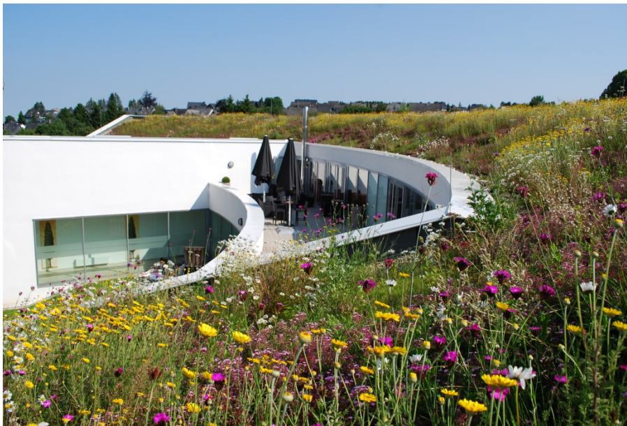
Abbildung 9 Extensive Dachbegrünung des Oversum Vitalresorts in Winterberg, Baujahr 2012 (Foto © OPTIGRÜN).
