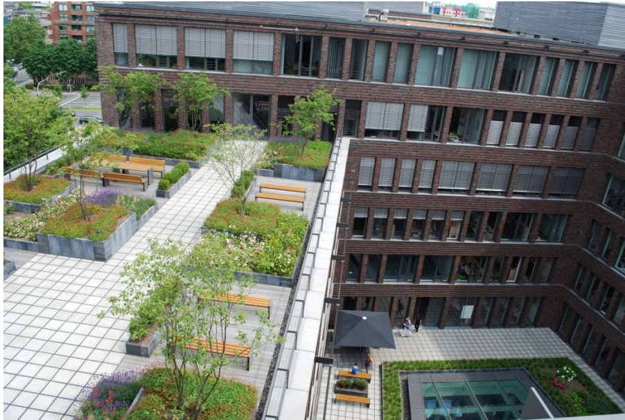
Abbildung 2 Intensiv begrüntes Dach / Dachgarten auf einem Verwaltungsgebäude am Dortmunder U in Dortmund, Baujahr 2010 (Foto © OPTIGRÜN).
